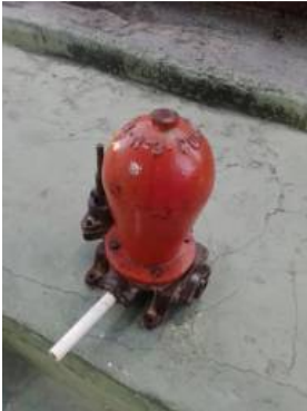
Bomba hidráulica carneiro N° 3 R$ 1
